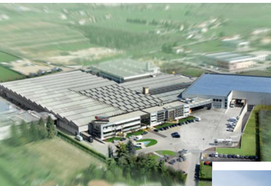
Stabilimento La Nordica Montecchio Precalcino
